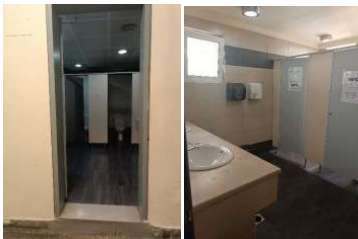
24. Κεντρικό κτίριο, τυπικό WC υπογείου
